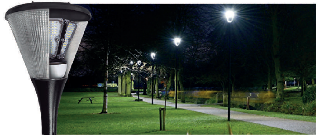
*Ejemplo de instalación punta poste
